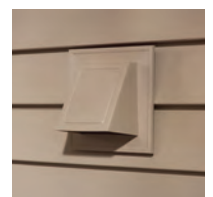
DRYER HOOD RESPIRADERO CON CUBIERTA SECADORA
